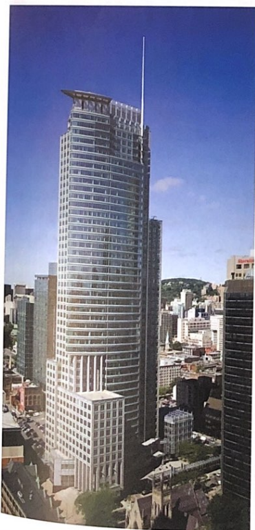
L'entreprise a installé une ligne de vie au sommet de la deuxième plus haute tour de Montréal.
