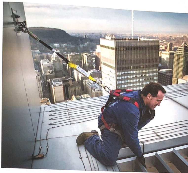
Petits et compacts, ces ancrages de toiture sont beaucoup plus efficaces que les méthodes conventionnelles.
